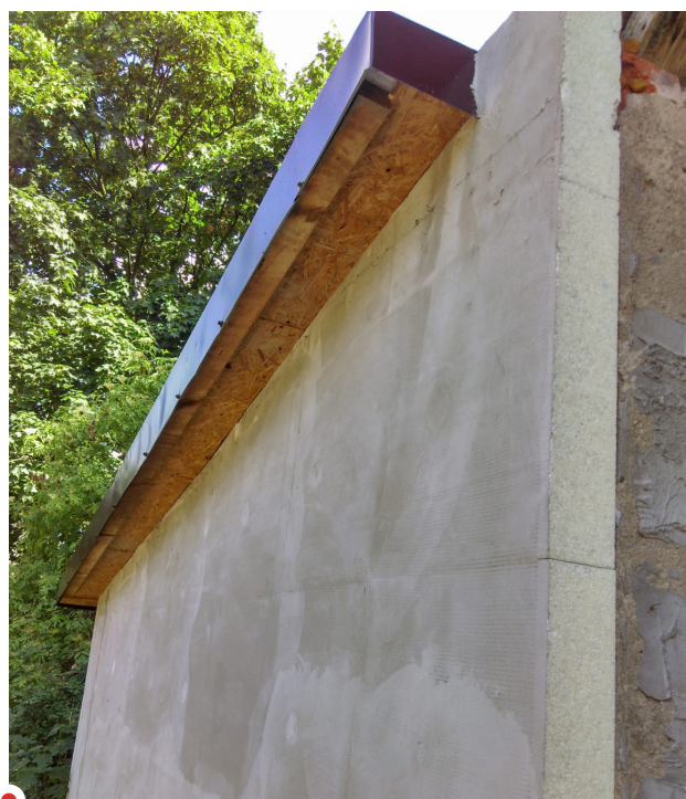
Ocieplenie pozbawionych izolacji ścian zewnętrznych pozwoli ograniczyć straty ciepła. Termomodernizacja budynków mieszkalnych i inwentarskich w pośredni sposób może też przyczynić się do oszczędzania energii elektrycznej, zmniejszając konieczność dogrzewania pomieszczeń. (Fot. Maria Tupalska)
